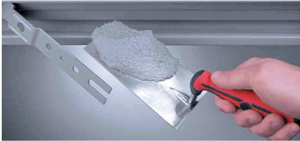
Nel caso di fissaggio con zanche, si consiglia di creare gli scassi adeguati nella parete (sezione 80 x 200 mm). Le zanche vanno ripiegate e bloccate nella parete. Ai fini della tenuta al fuoco e della tenuta meccanica, il vuoto tra telaio e muratura deve sempre essere riempito con malta cementizia.
